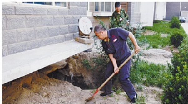
■工作人员正在填坑作业。
