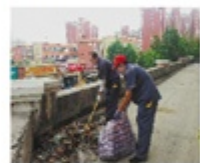
安邦物业处清理雨水口。
