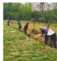
■物业员工进行挖沟埋管。
