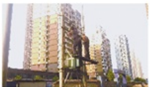
为保证及时供电 维修工连续战高温
