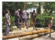
■抢修故障现场。
