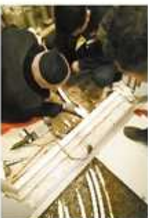
维修人员排除故障。
